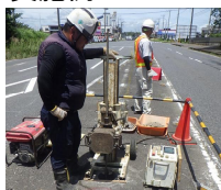
（貫入試験による調査）
