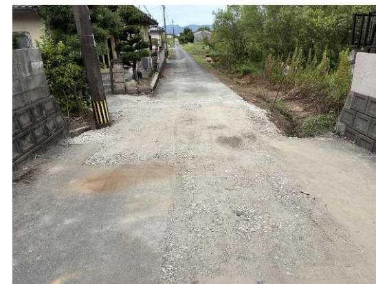
仮設配管設置後の路面状況（宇城市）
