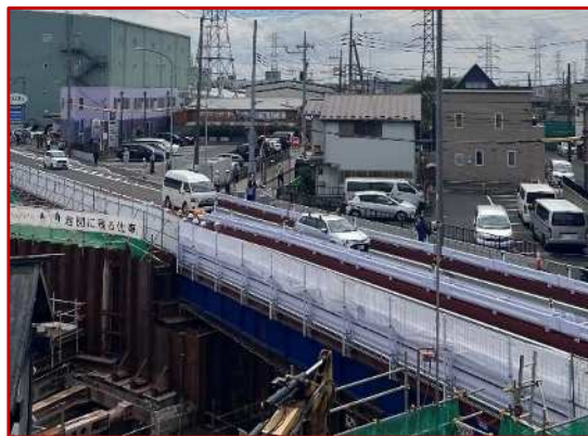
暫定2車線での供用開始(4/15撮影)
