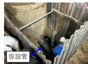
下水管路の応急措置状況
