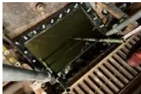
東電シールドに設けた開口 (約60cm×約45cm)
