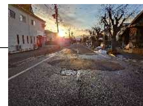
応急措置完了
