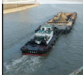
船による掘削土の搬出状況
