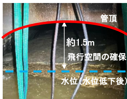
水位低下によりドローンの飛行空間を確保 (管径2.7m 通常時は満水)
