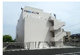
六名雨水ポンプ場
