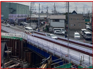
暫定2車線での供用開始(4/15撮影)
