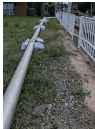
地上への仮設配管
