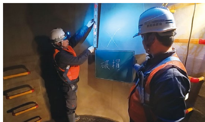
管路内の損傷箇所調査
