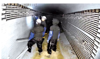
管内カメラから 施工状況をライブ中継
