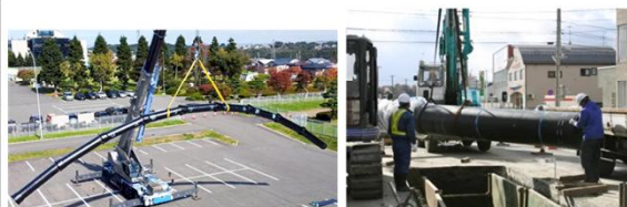
耐震型ダクトイル鉄管採用50周年セミナー （新耐震管GXφ500吊り上げ）
