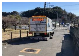
(空洞探査車による調査)
