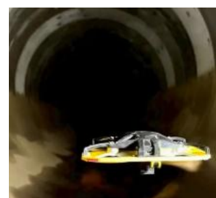
ドローンによる目視調査
