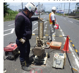
貫入試験による空洞調査
