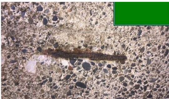
鉄筋が腐食し断面が欠損した状態の例①
