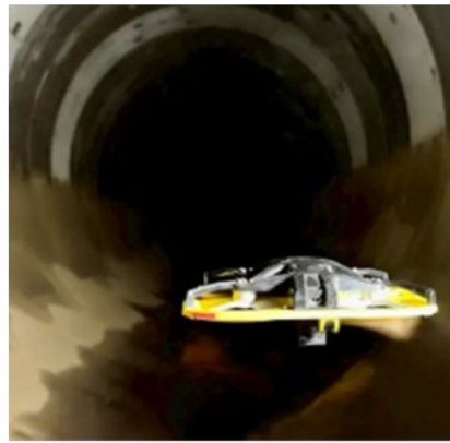
ドローンによる調査
