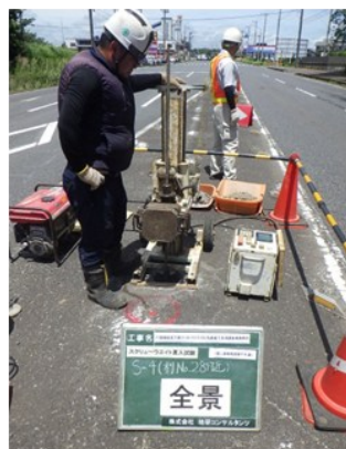
貫入試験による空洞調査
