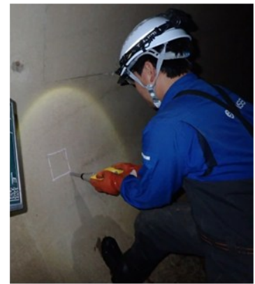
リバウンドハンマー による打音調査
