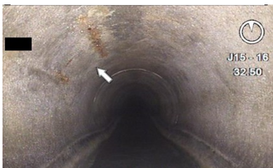
腐食した鉄筋の錆汁が発生している状態の例①
