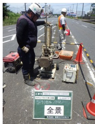
貫入試験による空洞調査
