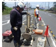
（貫入試験による調査）
