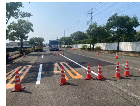
応急復旧状況(八代市)
