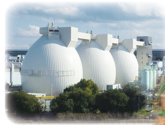
バイオガスを生み出す 消化タンク
