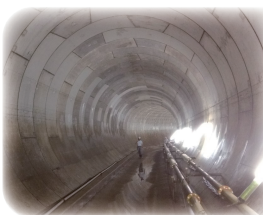
雨水貯留施設
