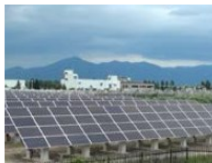
山形県 山形浄化センター
