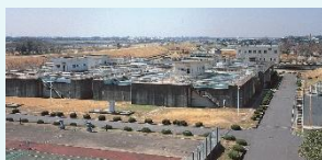
茨城県企業局利根川浄水場
