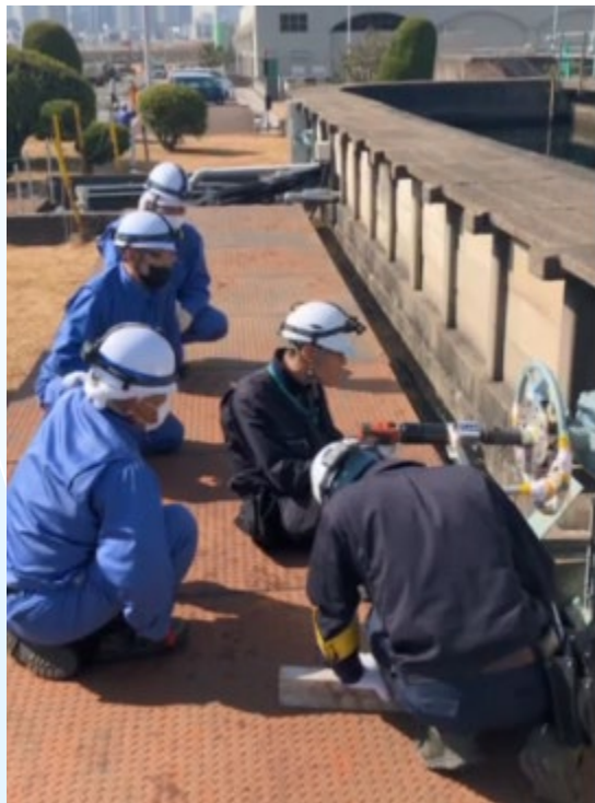
手持ち型電動式バルブ開閉工具使用状況
