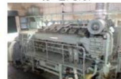
例：自家用発電機の整備
