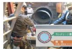
例：管路の耐震補強
