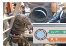
例：管路の耐震補強
