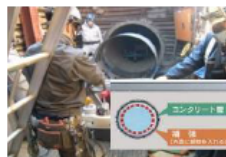
例：管路の耐震補強
