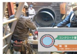
例：管路の耐震補強
