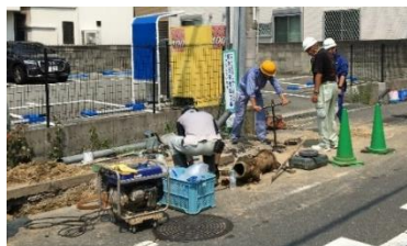
断通水作業状況
