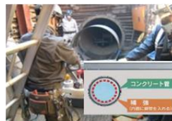
例：管路の耐震補強
