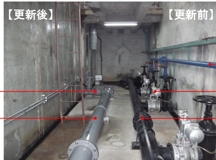
写真 レシプロ式汚泥掻寄機の採用による更新前後の状況(排泥管廊)
