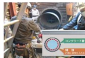
例：管路の耐震補強
