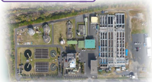
西部浄化センター
