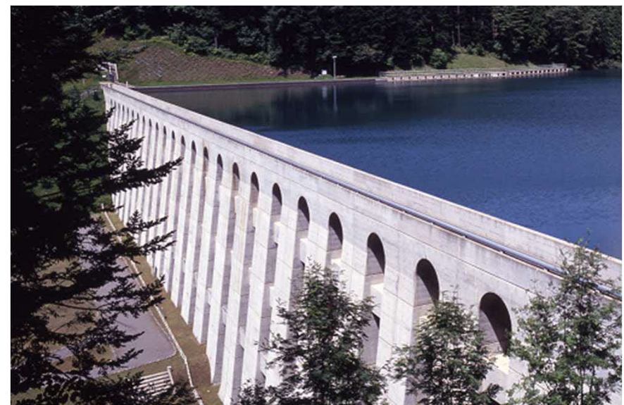
現在 (S60 改修)
