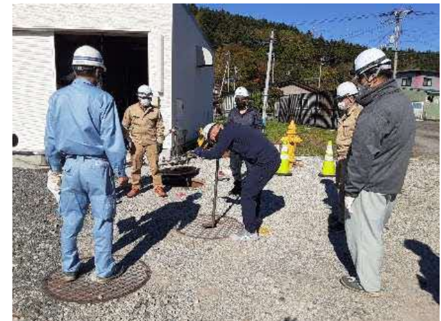
研修状況（仕切弁操作）
