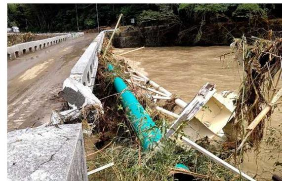
流木等が堆積し落橋した水管橋
