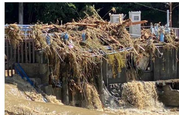
流木・土砂等の流入により閉塞した取水施設
