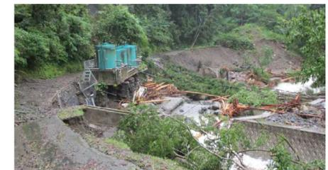
土砂崩れ等で破損した取水施設
