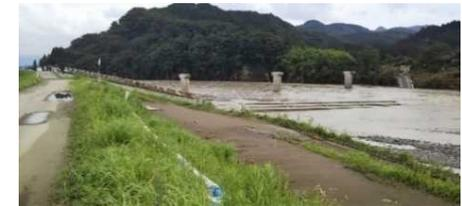
送水管を添架していた道路橋の流出
