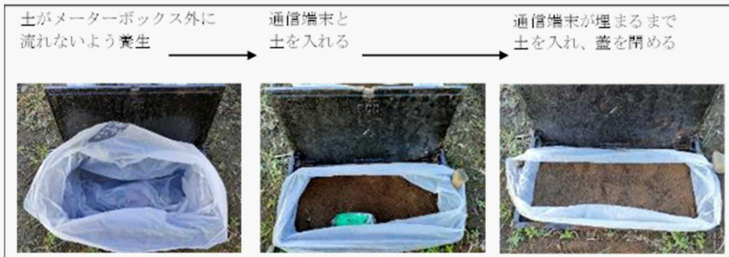
図6.3.22 メーターボックス内を埋設実験状況
