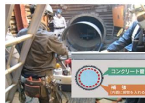
例：管路の耐震補強
