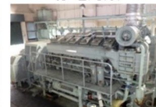
例：自家用発電機の整備
