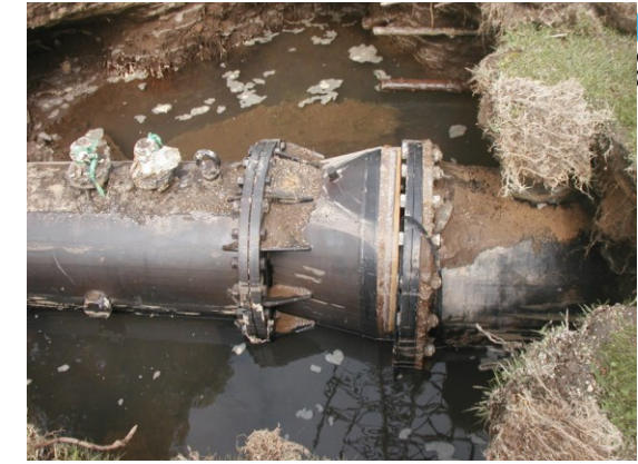
廃止された電磁流量計 ルーズフランジの抜き出し 平成28年4月16日 9:00
