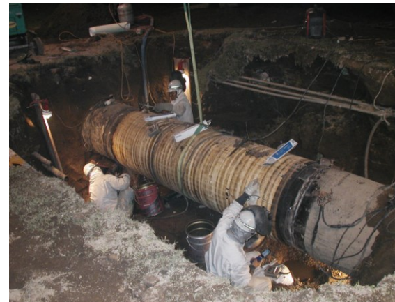
プラスチック被覆鋼管 φ800耗にて復旧 平成28年4月17日 7:00
