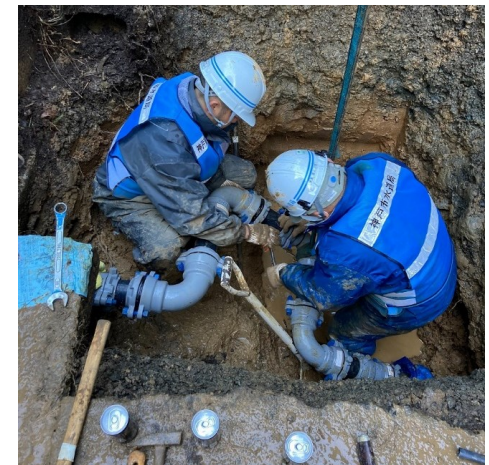
穴水町 管路修繕(神戸市)
