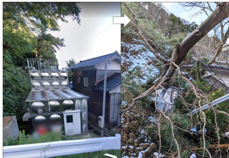
稲船ポンプ所損壊(輪島市)
