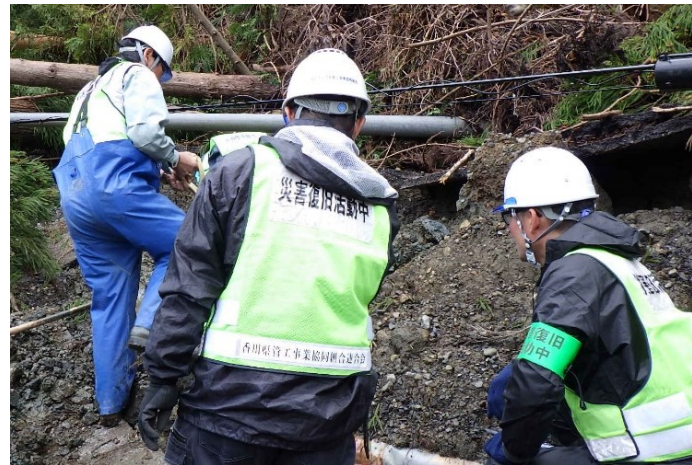
輪島市 斜面崩落箇所での復旧作業 (香川県広域)
