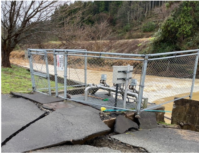
宝立浄水場・鵜飼川取水口(珠洲市)
