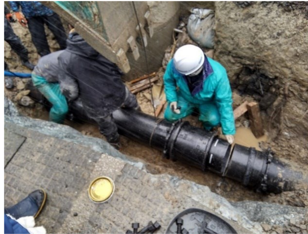
輪島市 送水管復旧工事(横浜市)
