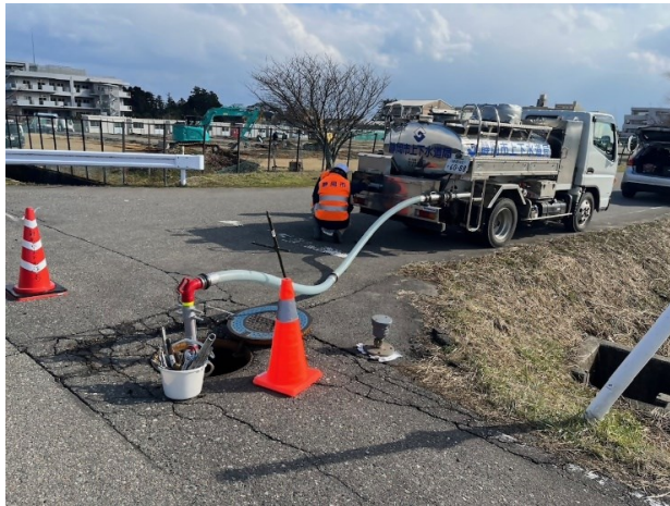
給水車による漏水調査(静岡市)
