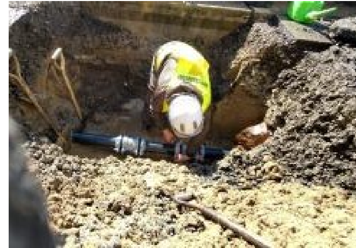
輪島市 管路修繕(高知市)
