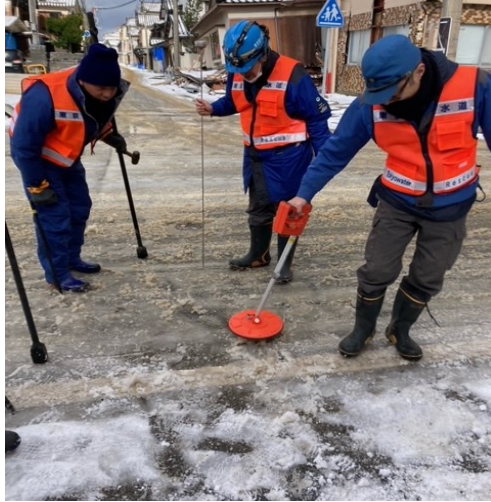
輪島市 雪中での漏水調査 (東京都)
