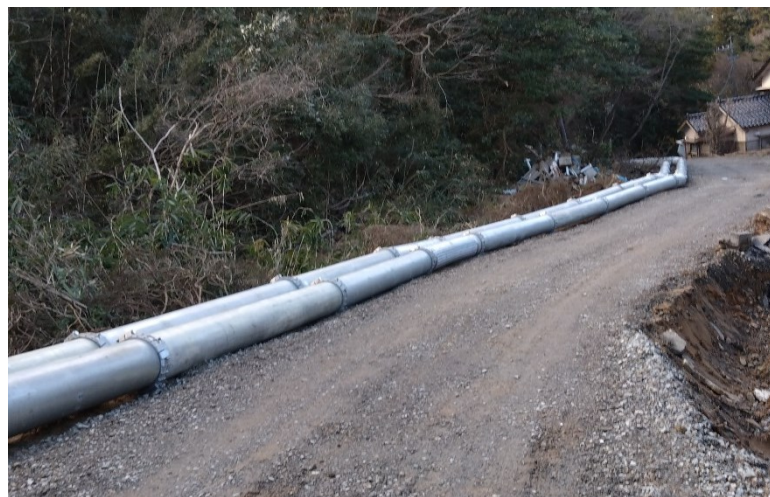
輪島市 送水管復旧
