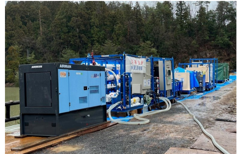
珠洲市亀ヶ谷(かめんた)池に設置した可搬式浄水施設・設備
