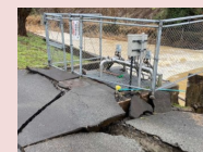
水道の復旧（被災した浄水場）
