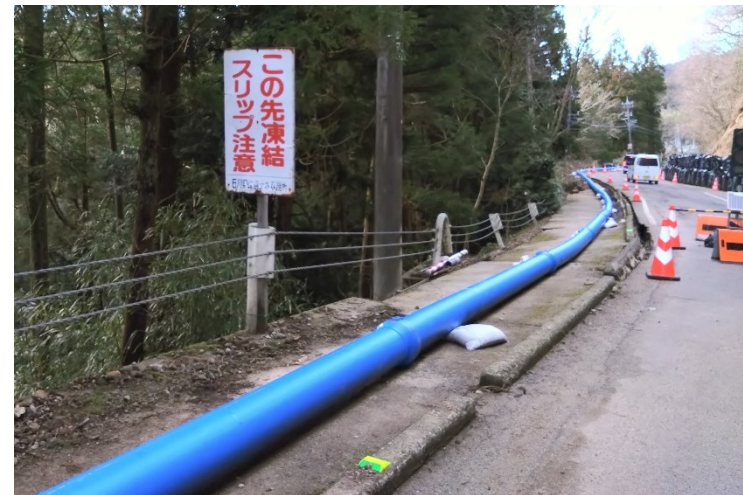
輪島市 配水管復旧
