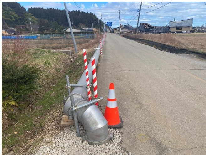
珠洲市 送水管復旧
