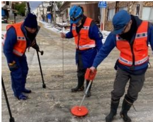
輪島市漏水調査 (東京都水道局)
