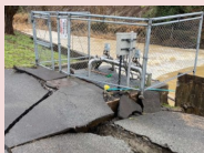
水道の復旧（被災した浄水場）
