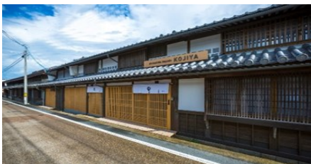
旧苅田家付属町家群を活用した公共施設等運営事業 (岡山県津山市)
