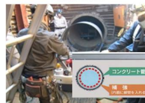
例：管路の耐震補強
