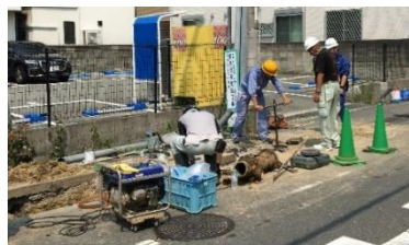
断通水作業状況
