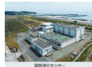
富岡浄化センター
