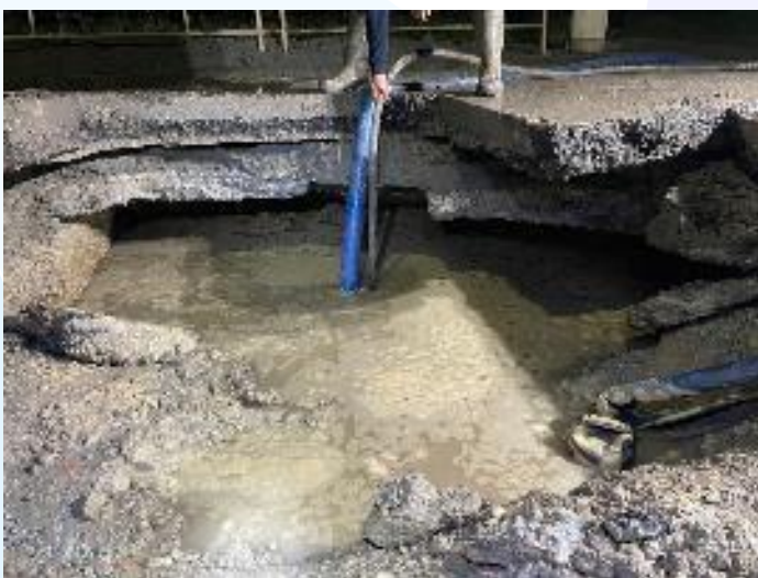
漏水状況（左）とその後の管体調査（右）
