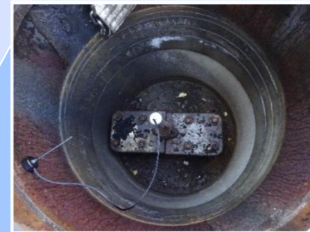
漏水音センサ設置状況
