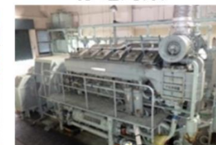
例：自家用発電機の整備
