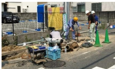
断通水作業状況
