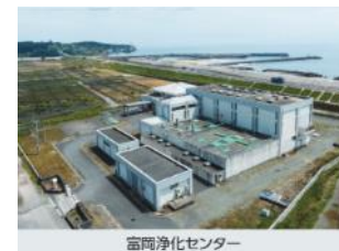
富岡浄化センター
