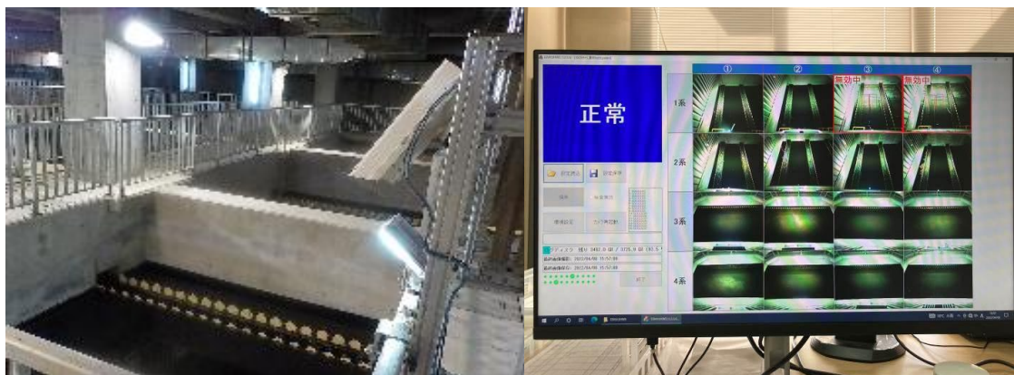
画像監視装置（Webカメラ） （最終沈殿池）
