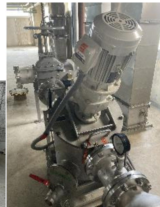
モノカッター設置 （重力濃縮棟）
