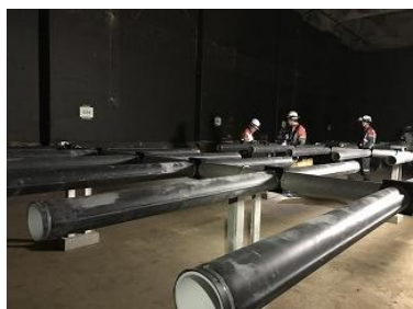
低圧損超微細気泡方式の散気装置
