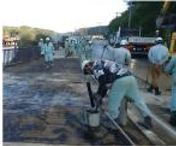
陥没した歩道の仮復旧状況
