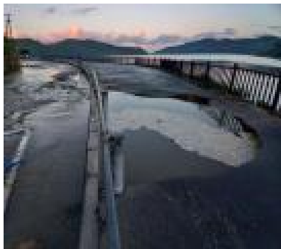
導水管破損による歩道冠水 状況（導水停止後）
