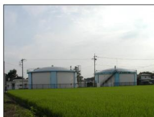
北部配水区 配水池(増設) (第 2 次拡張)
