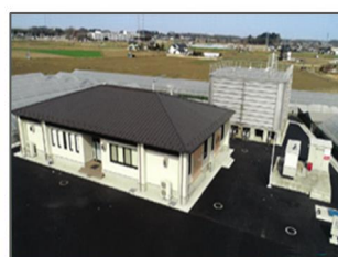
南部配水区 配水場 (更新後)
