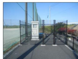
中央配水区 第 3 水源 (第 3 次拡張 1 変)
