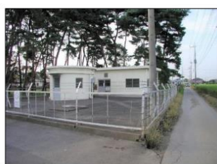
北部配水区 第 1 水源 (創 設)
