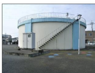
北部配水区 配水池 (第 1 次変更)
