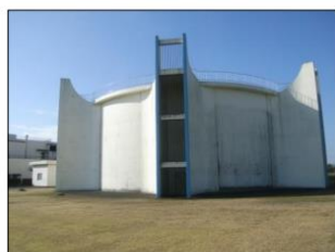
中央配水区 配水池 (第 1 次拡張)
