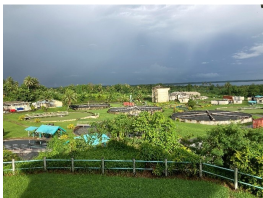
下水処理施設全景①
