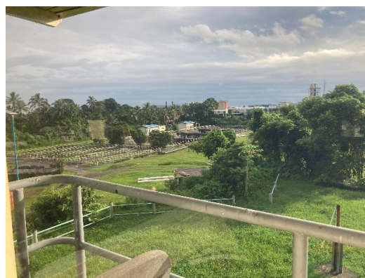
下水処理施設全景②
