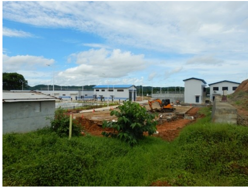
浄水施設全景
