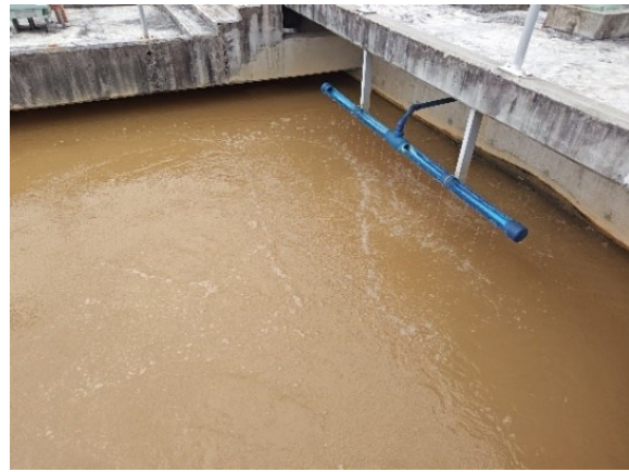
ポリマー注入口
