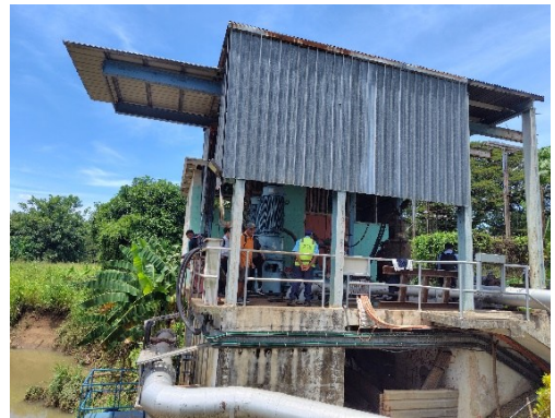
取水ポンプ場
