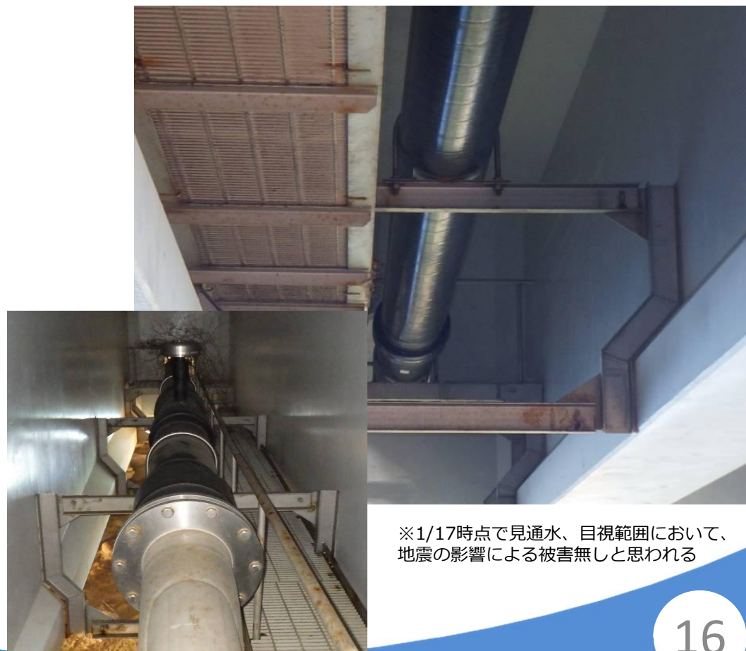
【能登島大橋添架水管橋 \phi 500 】
