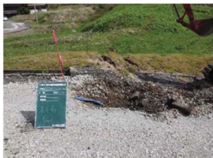
試掘前の状態
