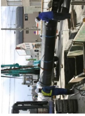
耐震管の布設工事
