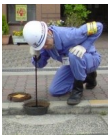
漏水調査状況
