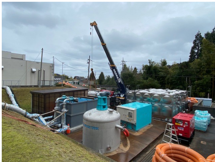
珠州市宝立浄水場に設置した可搬式浄水施設
