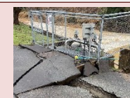
水道の復旧 (被災した浄水場)
